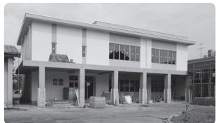
建設中(7月6日現在)
